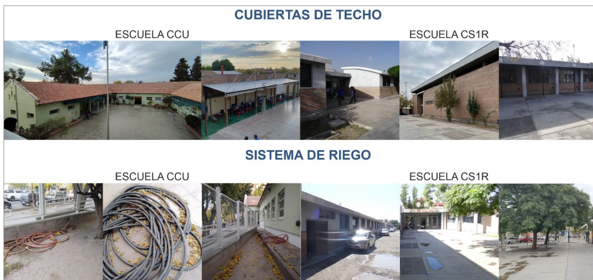
Figura 7 Cubiertas de techo en CCU y CS1R (sup.) y Sistema de riego en CCU y CS1R (inf.).
